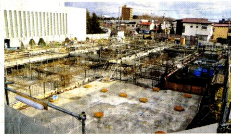
建設が進む「がん診療センター」＝昨年12月3日撮影
